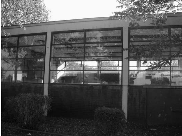
Turnhalle mit einfachverglasten Fenstern
