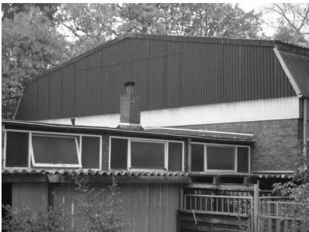
Alte Turnhalle mit Umkleiden
