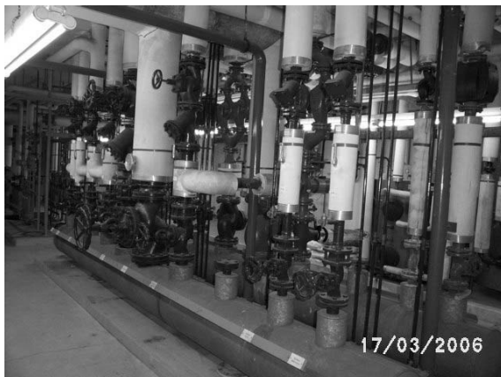
Heizungsverteiler
