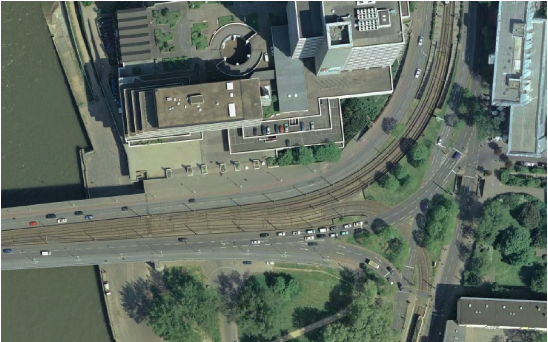
Deutzer Brücke in Köln rechtsrheinisches Rampenbauwerk (BW-Nr. 69-3120)
