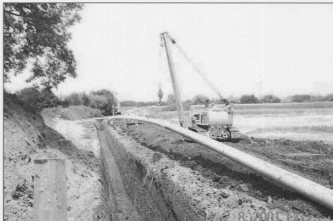
Absenken eines vorgefertigten Rohrstrang.
