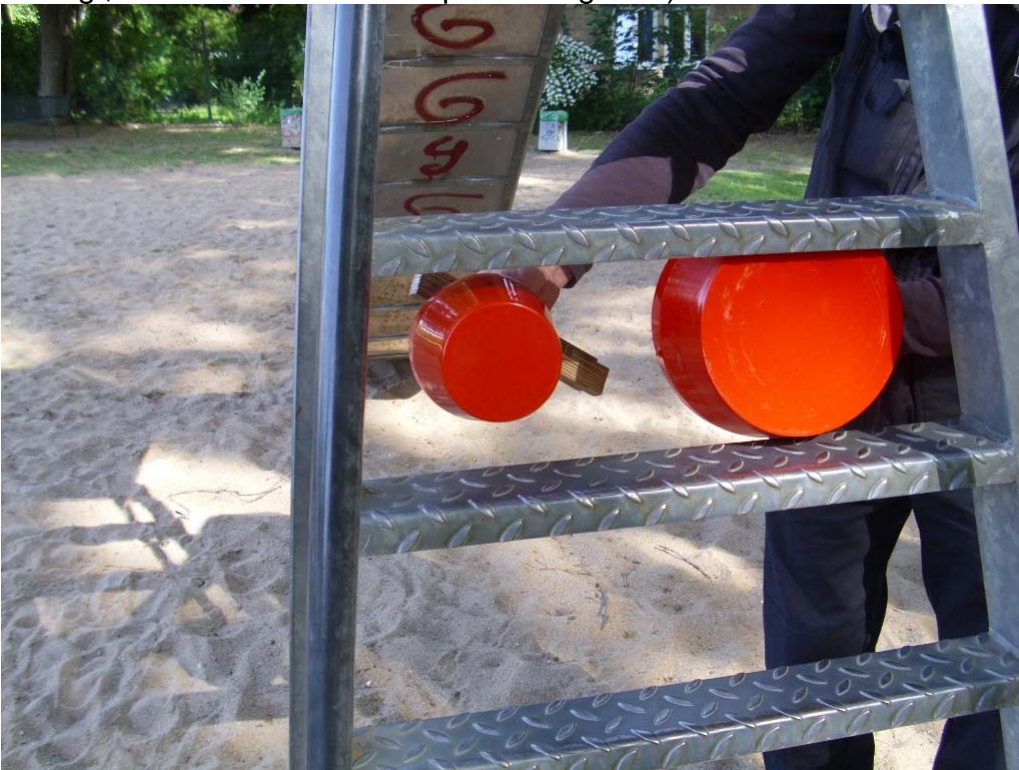
Abb. 4: Fangstellen zwischen den Sprossen des Rutschenaufstieges. Um den Vorgaben der DIN EN 1176 zu entsprechen, müssten sich beide Prüfkörper durch die Öffnungen führen lassen – oder keiner der beiden Prüfkörper: es liegt eine unzulässige Fangstelle für Kopf und Hals vor (Prüfkörper klein: Kopffangstelle; Prüfkörper groß: Körperfangstelle).
