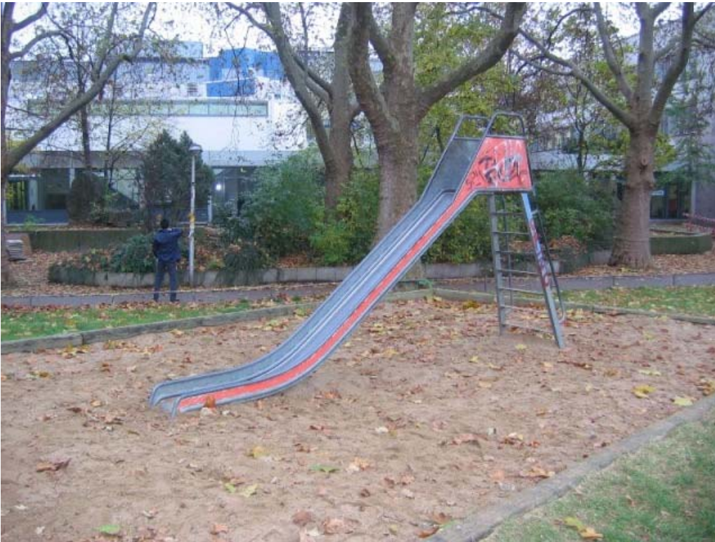
Abb. 1: Nicht normgerechte Rutsche. Fangstellen für Kopf und Hals zwischen dem Sprossenaufstieg und den Handläufen, zwischen den Sprossen und in den Wangen des Einsatzbereiches.
