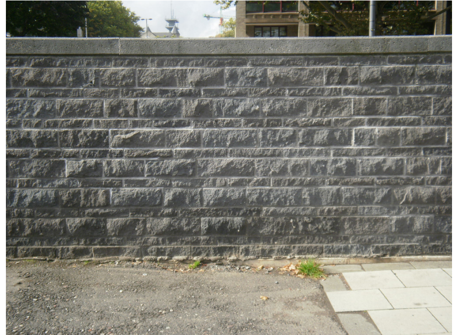
Blick auf Verblendung Hochwasserschutzmauer
