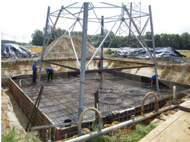
Abbildung 10 Montage der Fundamentbewehrung
