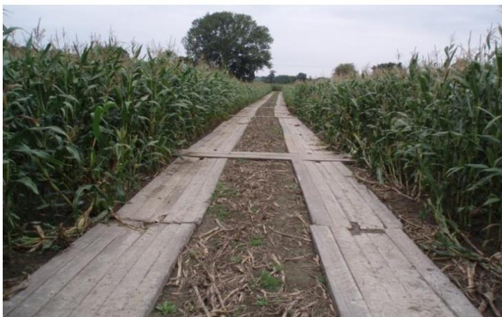
**Abbildung 8**      Temporäre Zuwegung über Fahrbohlen
