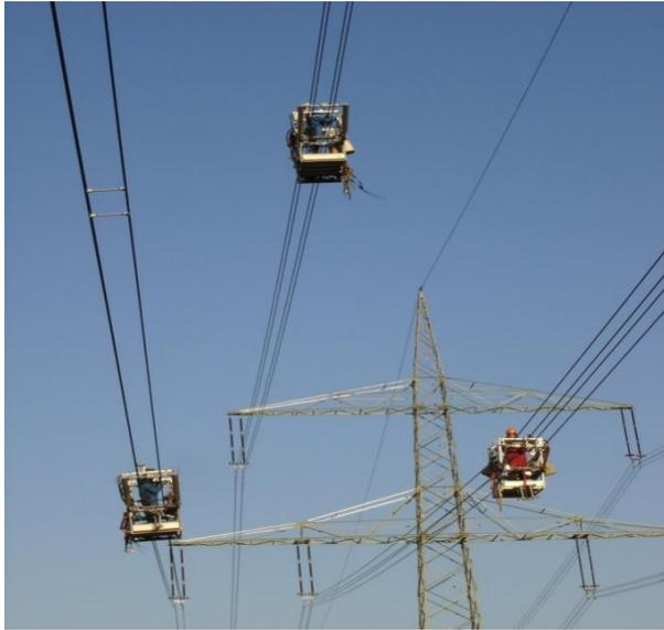
Abbildung 17 Montage der Feldbündelabstandhalter mit Fahrwagen
