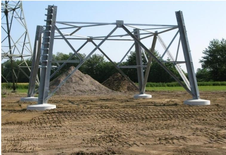
**Abbildung 12 Montierter Mastfuß**
