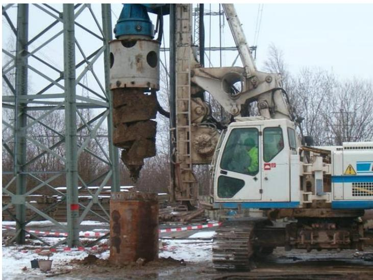
Abbildung 11 Bohrung für einen Bohrpfahl
