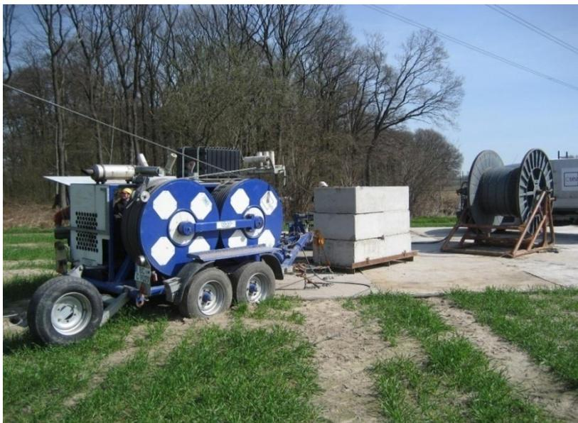
**Abbildung 16** Windenplatz eines 4er-Bündel-Seilzuges
