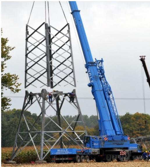
Abbildung 13 Mastmontage (Stocken)
