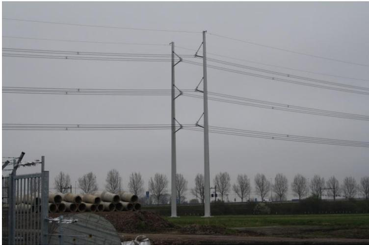
Abbildung 5 Wintrackmast mit zwei 380-kV-Stromkreisen
