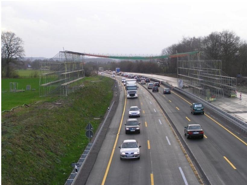
**Abbildung 15** Stahlrohrschutzkonstruktion mit Netz über einer Autobahn
