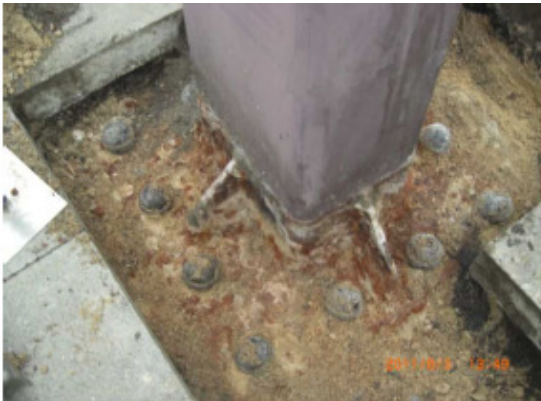
ENTWAESSERUNGSOEFFNUNG AM STIELFUß FEHLT
