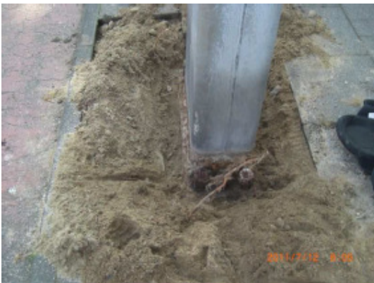
ENTWAESSERUNGSOEFFNUNG AM STIELFUß FEHLT
