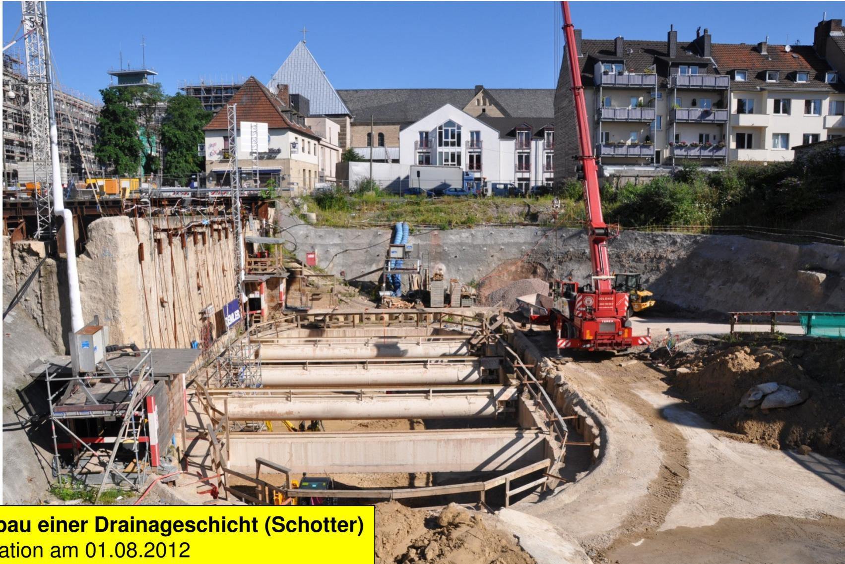
**Einbau einer Drainageschicht (Schotter)**
