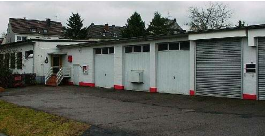
Bild 1: Fahrzeughalle von vorne
