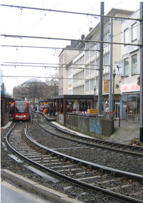
Masten seitlich der Gleise
