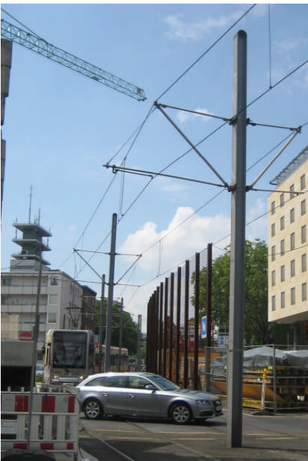
Masten zwischen den Gleisen
