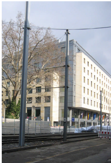
Masten seitlich der Gleise
