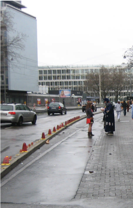
Betonpfähle entlang der Cäcilienstraße
