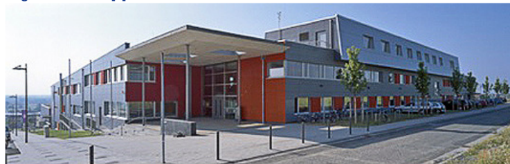
Nordwest-Ansicht des Schulgebäudes
