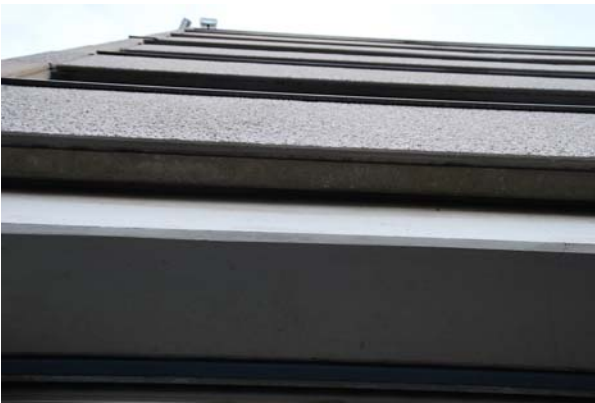
Abbildungen der Fassade Bauteil A und Fenster
