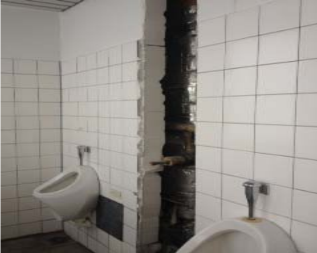
Abbildung einer Toilettenanlage im 3. Obergeschoss Bauteil A
