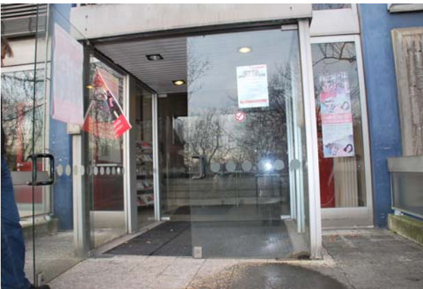
Abbildung des Haupteingangs Bauteil A
