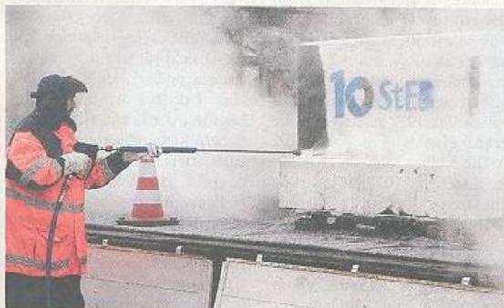
Wenn nichts mehr zu helfen scheint, hilft der Dampfstrahler: Mit einem Druck von 300 Bar entfernen AWB-Mitarbeiter Graffiti. BILD: WORRING
