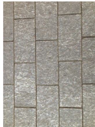
Betonsteinplatten 30/15/8 mit Natursteinvorsatz (oberflächengeflammt Granit) in Kombination mit Betonsteinpflaster 8/8/8, anthrazit, Verlegemuster analog nördlichem Bereich der Hohe Straße
