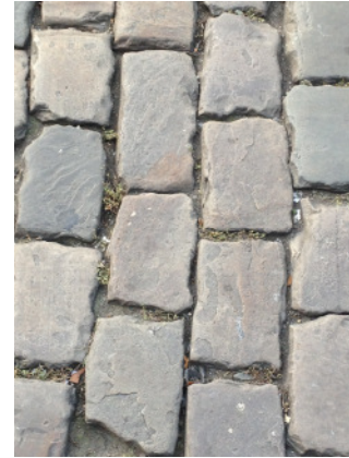
Fahrbahn Casinostraße Grauwackegroßpflaster in Segmentbögen
