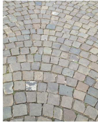
Kernzone Grauwackekleinpflaster 8/8/8 cm in Segmentbögen
