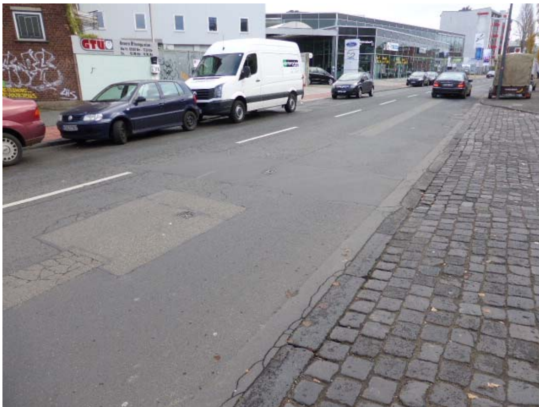
Bild 4: Oskar-Jäger-Straße, Blickrichtung Süd, gegenüber Haus-Nr. 168
