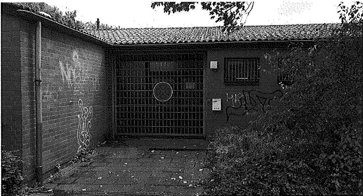
Außenansicht Vereinsheim Straßenseite
