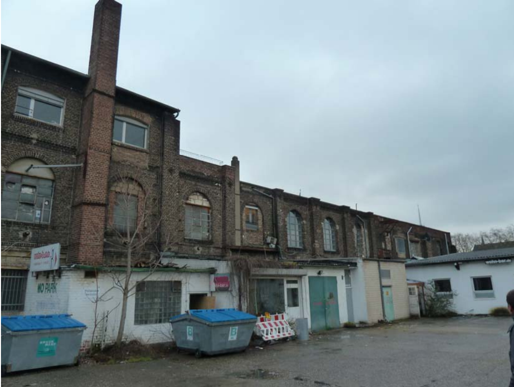
Abbildung: Fassade der Rheinlandhalle zum Schulgrundstück hin, Abbruch der neuen Anbauten, Sanierung der historischen Fassade, Bereich für eine mögliche Aufstockung
