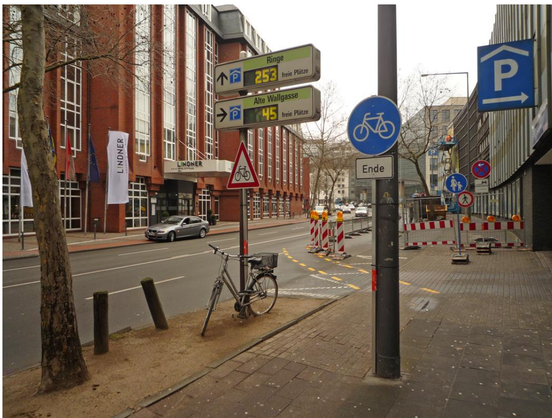
Radweg endet und wird mit Furt auf die Fahrbahn geführt. Die Furt endet zu früh und entspricht nicht den Vorgaben der AGFS. Magnusstraße Februar 2015
