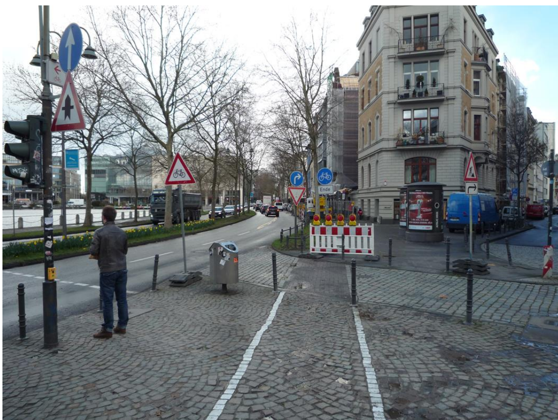
Radweg endet ohne sichere Weiterführung vor der Baustelle – Maybachstraße seit April 2015
