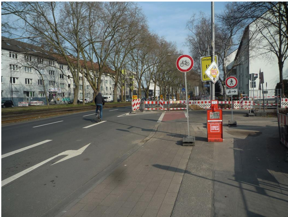
Radweg endet „alternativlos“ vor der Baustelle – Ehrenfeldgürtel März 2015
