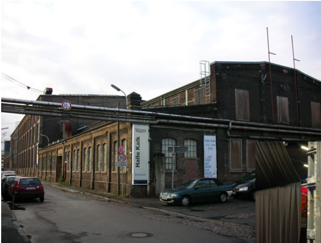
Abb. 4 Halle 75 (im Vordergrund) - Foto 2008 41,38 m lang x 29,90 m breit; Höhe im Mittelschiff etwa 8,40m
