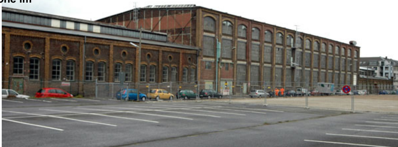
Abb. 6 Maschinenfabrik Humboldt: Hallen 77, 76 und 75 (von links nach rechts) - Foto 2008 (Gesamtlänge 175 m)
