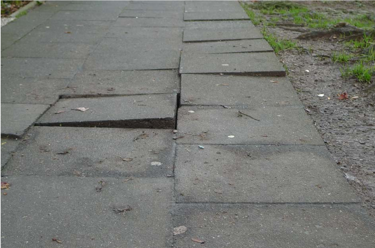
Gehwegbelag Lothringer Str. 23
