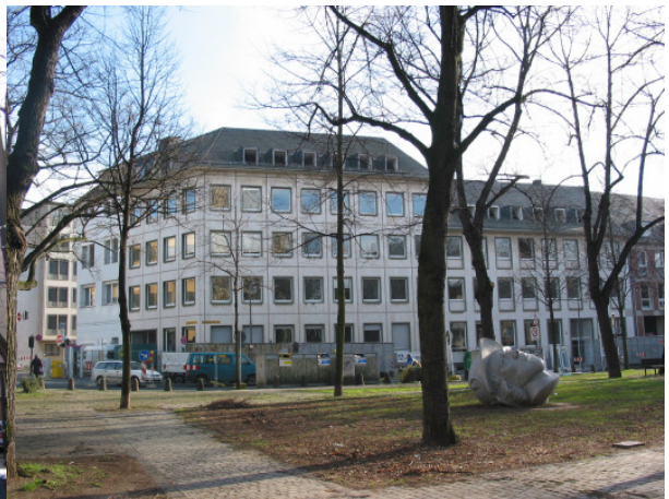
Bild 2: Gereonsdriesch, Altstadt Nord Abriss/ Neubau
