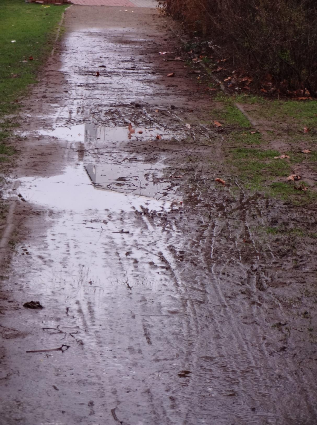
Anlage 1 zu SPD-Antrag vom 10.3.2017 Sanierung Fußweg Urbach
