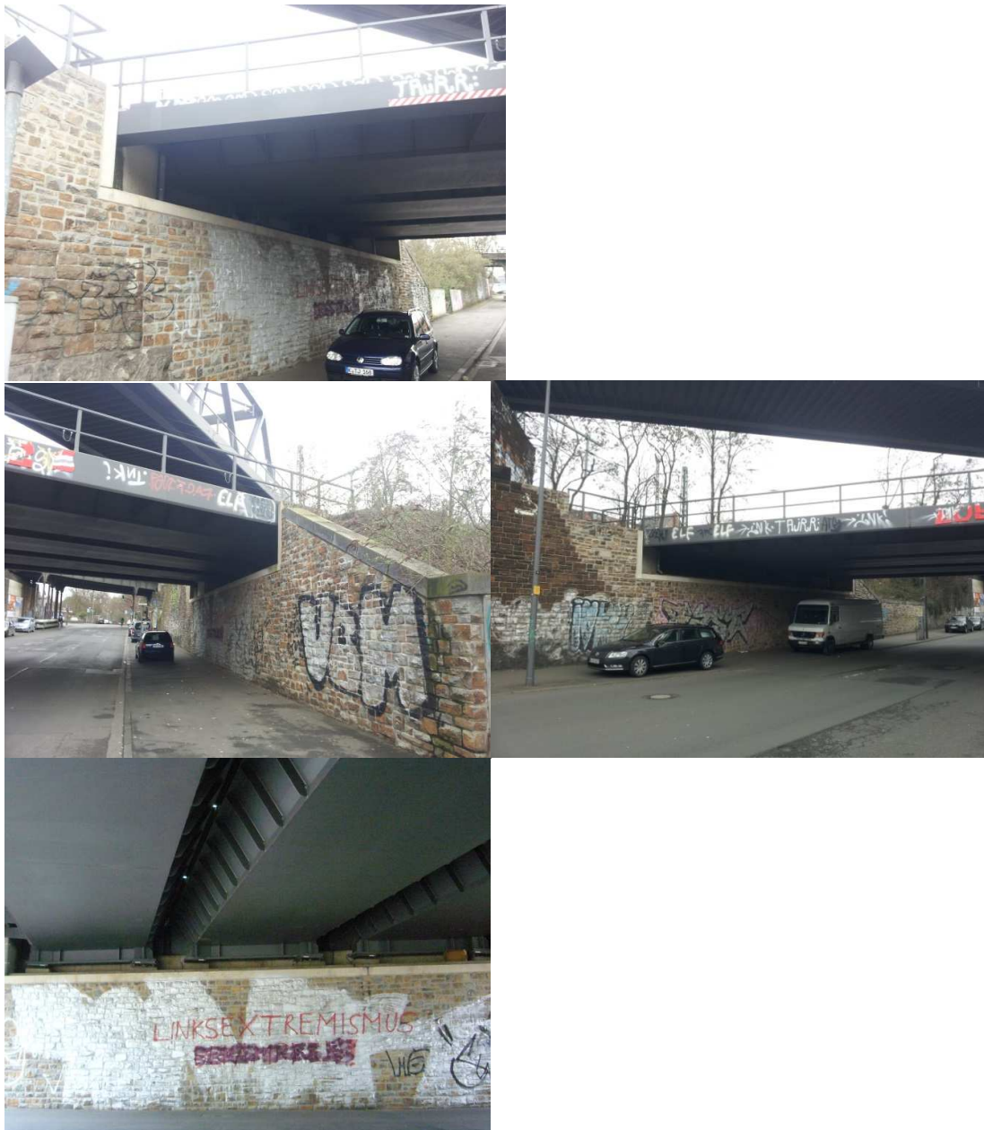
Fotos des Neubaus am Eifelwall (mittlere Brücke)
