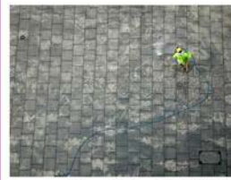
Reinigen von Betonplatten mit dem Hochdruckreinger
