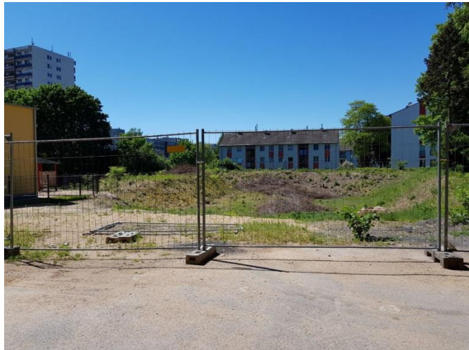
Blick über Schwimmbeckengrube zur Nachbarbebauung
