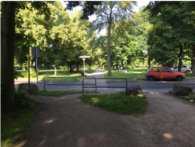
Blick von West nach Ost auf die Merheimer Straße – funktionslose Absperrung vorhanden
