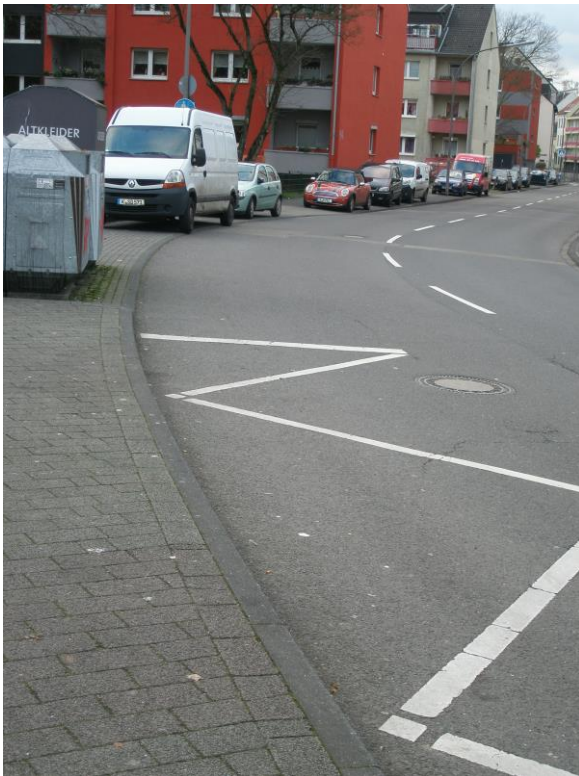
Hinter dem weißen Lieferwagen ist die Rückansicht von dem Zeichen für den gemeinsamen Fuß- und Radweg. Verdeckt ist das Verkehrszeichen, das ab dort der Fußweg beginnt. Von dort bis zur Grenzmarkierung für Halt- und Parkverbote (Zickzack – Linie) [Zeichen 299] soll der Fahrradschutzstreifen eingerichtet werden.
