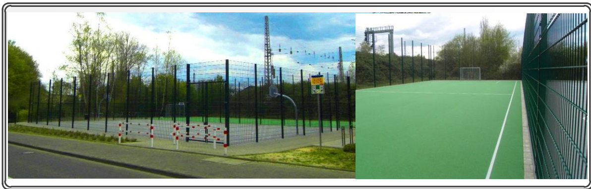
Longerich: Neuanlage Bolzplatz Heckweg
