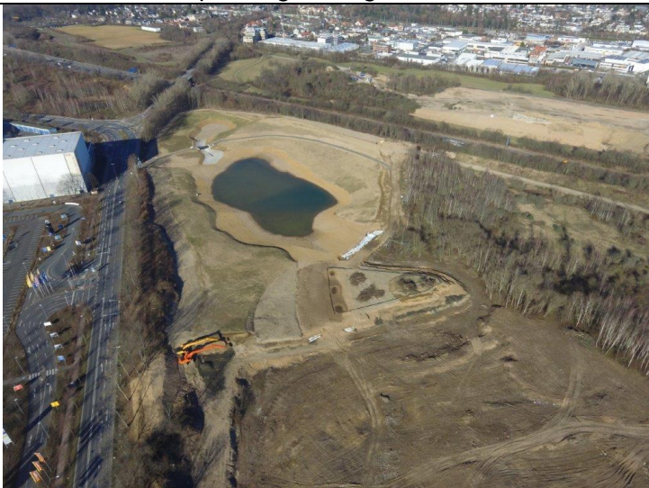
Auf dem Luftbild erkennbar: Fertiggestellter Bauabschnitt 1 mit bereits gefülltem Rückhalteteich und in der Bildmitte temporären Ersatzbiotopen für Kreuzkröten. Im Bildvordergrund gerodete Fläche für den Bauabschnitt 2
