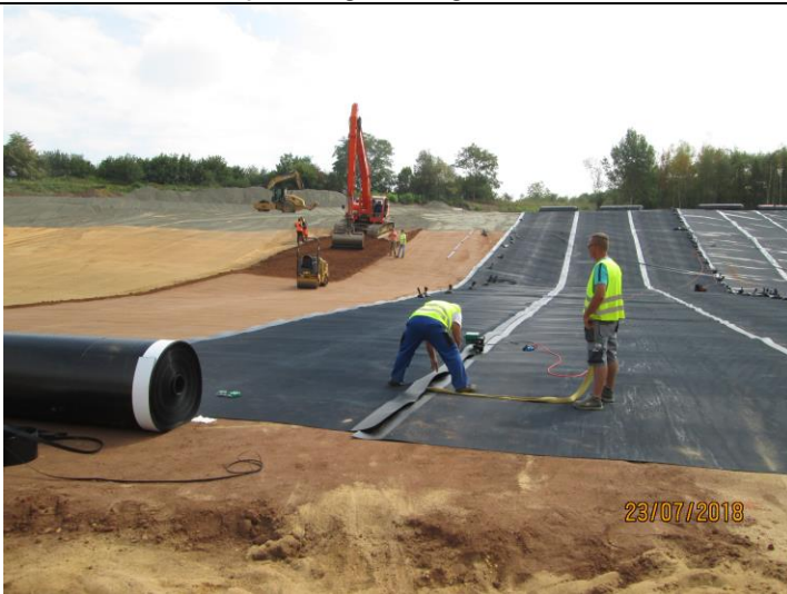
Einbau von Trisoplast und die Verlegung der Kunststoffdichtungsbahn im Sommer 2018
