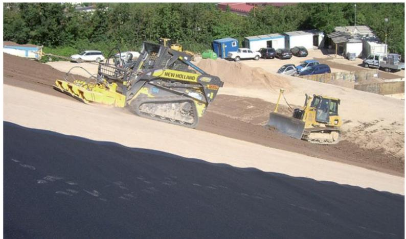
Nach Abschluss der Profilierungsarbeiten wird die Gasdrainage eingebaut. Anschließend wird eine Sandschicht als Auflager der Kunststoffdichtungsbahn eingebaut.
