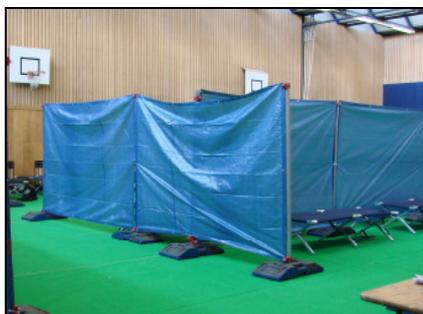
In einer der Turnhallen wurden Trennwände unter Zuhilfenahme von Gerätschaften aus der mobilen Verkehrsbeschilderung errichtet. So wurden jeweils 2,2 m hohe Sichtschutzplanken zwischen Vierkantrohre, welche mittels Fußplatten aufgerichtet wurden, verspannt.
