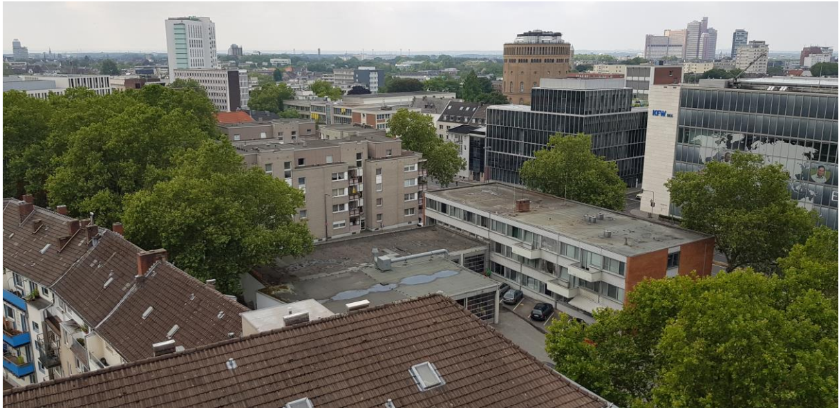
Abb.1: Ostansicht Hauptgebäude Feuer- u. Rettungswache 1 (Sternengasse Ecke Krummer Büchel)
