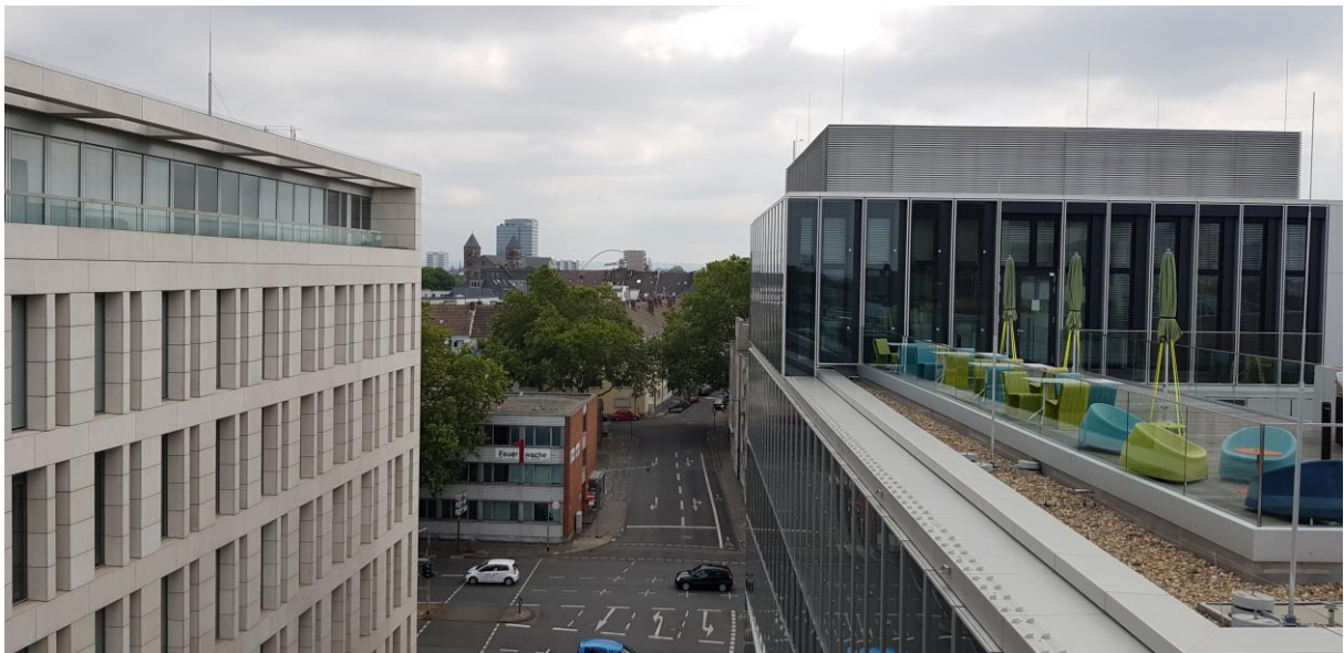
Abb.2: Westansicht Hauptgebäude Feuer- u. Rettungswache 1 (Agrippastrasse)
