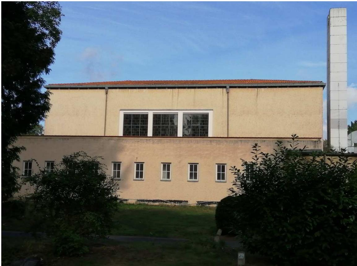
Ansicht Ost - Putzschäden, undichte Dachentwässerung
