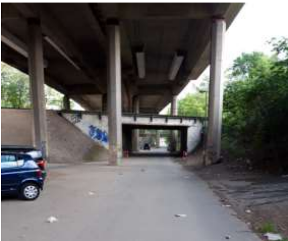
Foto 1: Brückenbauwerk der Bahn, das die Grundstücksfläche der Deponie Wiemersgrund von der Grundstücksfläche der Stadt Köln abgrenzt.
