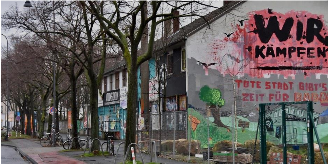
Außenansicht des AZ (vorher):
