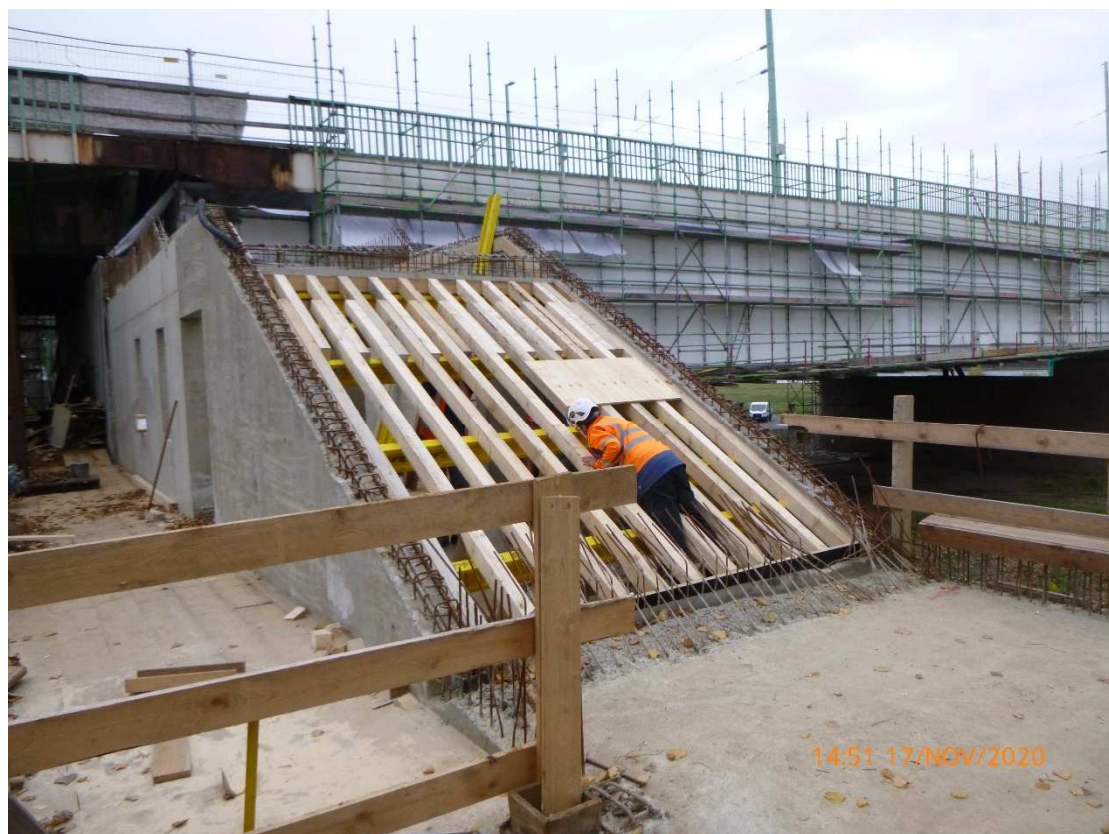
Bild 8: Herstellung der südlichen Treppenanlage im Bereich des Trennpfeilers
