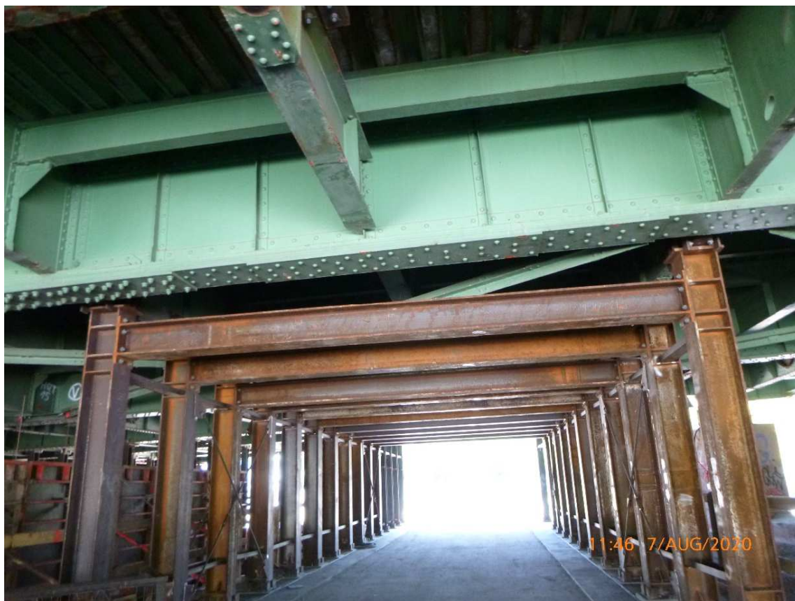
Bild 5: Temporäre Unterstützung des verbleibenden Brückenbauwerks
