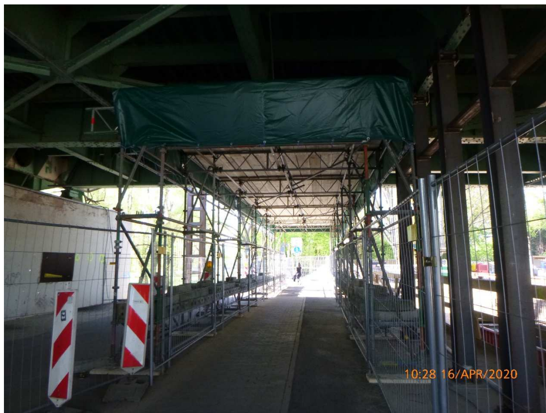
Bild 7: Schutztunnel Geh-/ Radweg
