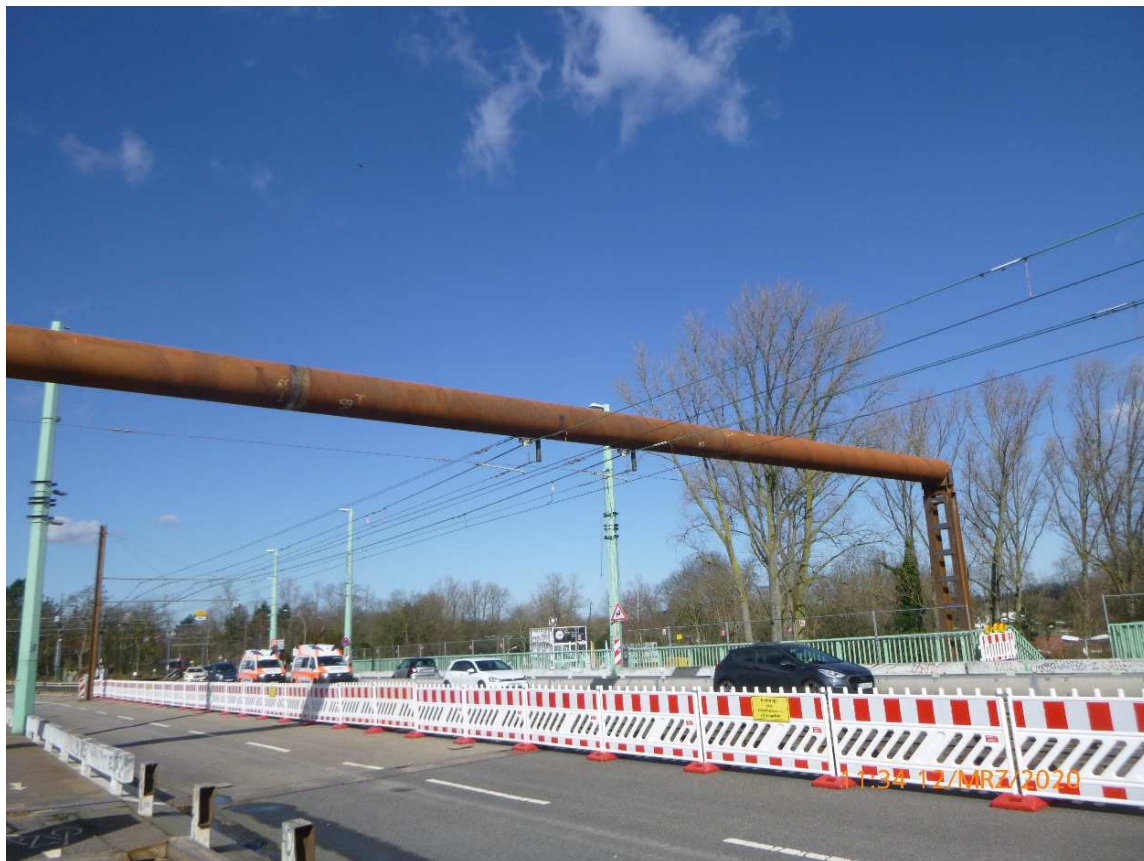
Bild 3: Umspannung der Oberleitung der Stadtbahn auf bauzeitlich errichtete Mastbrücke
