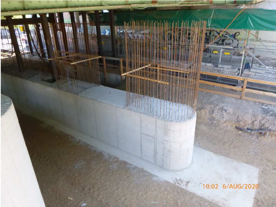
Bild 2: Herstellung Unterbauten
