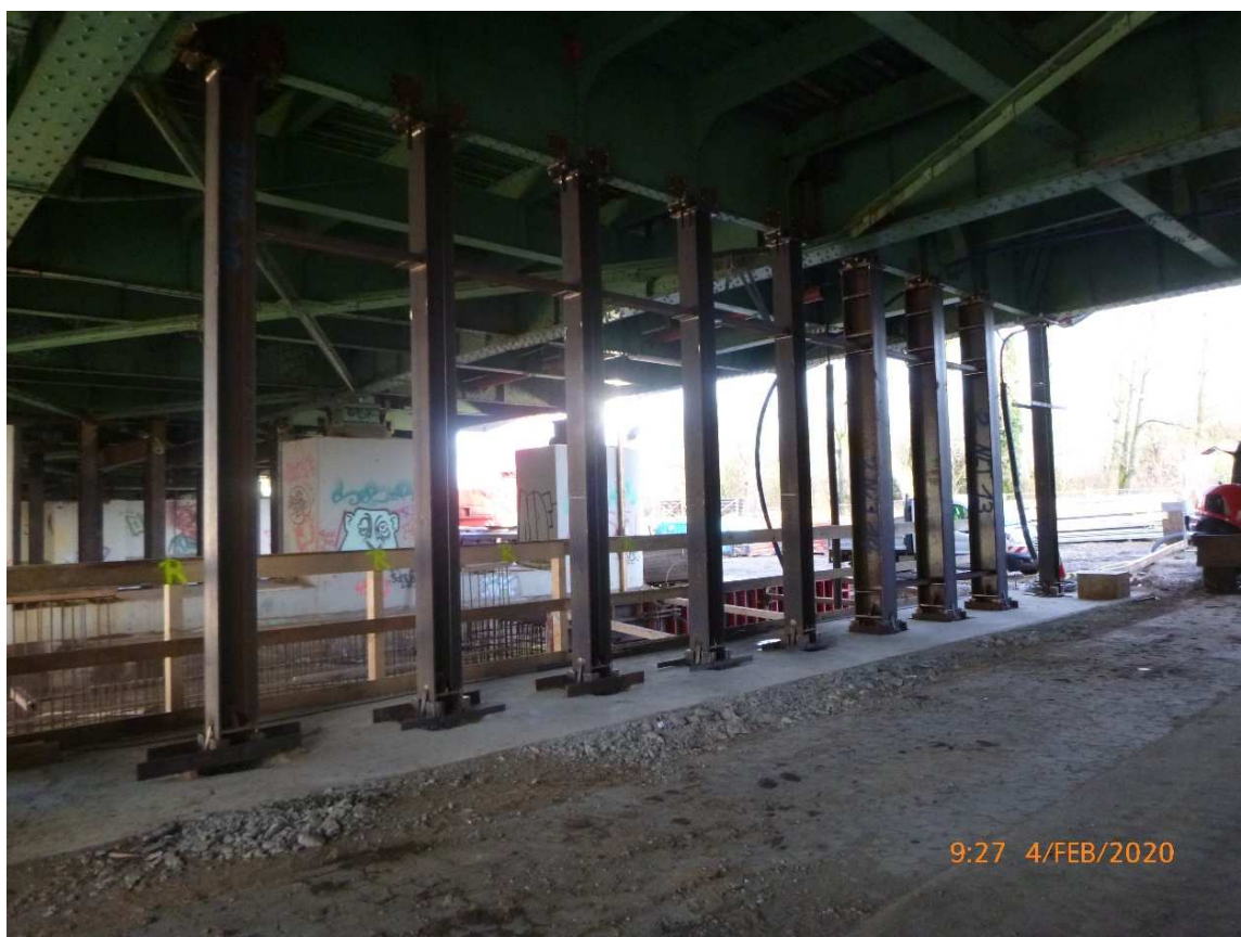
Bild 6: Temporäre Unterstützung des verbleibenden Brückenbauwerks
