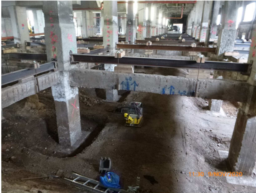
Bild 1: Aushub- und Sicherungsmaßnahmen
