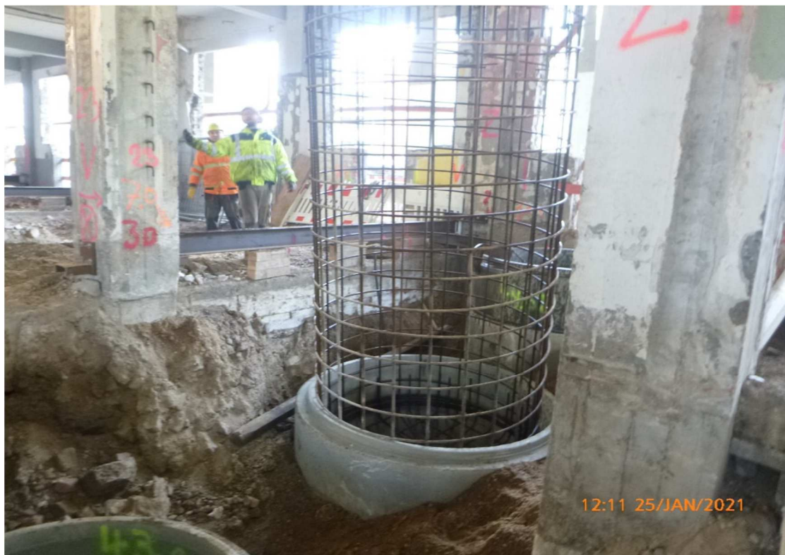
Bild 4: Montage/Einbau der Bewehrungskörbe der Brunnenringe
