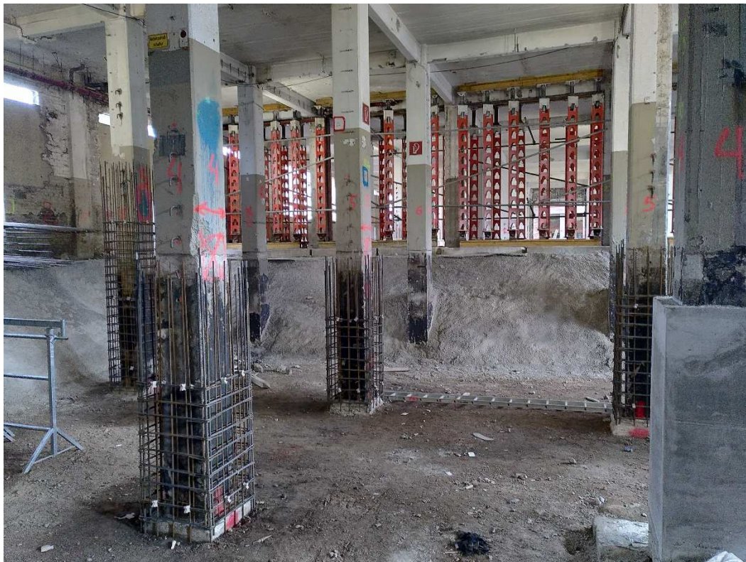
Bild 2: Erdaushub und Bestandsstützen mit Vorbereitungen für die Betonbandagen
