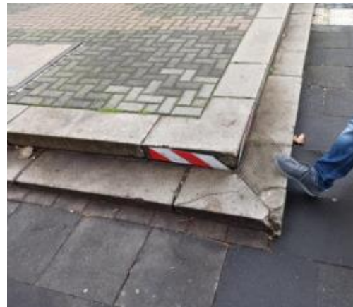
Übergang zum Bahnsteig Mauritiuskirche
