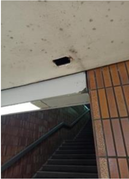
Decke Heumarkt, Übergang unterirdisch
