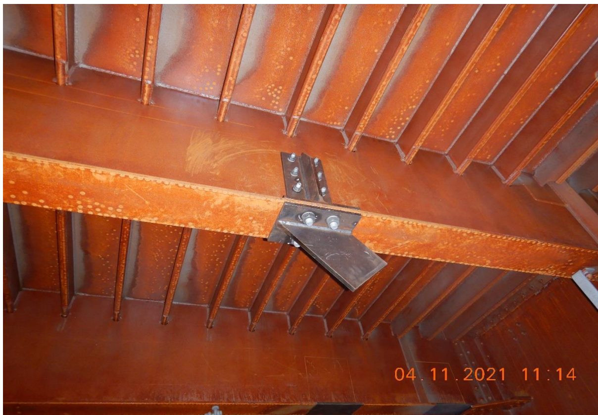
Bild 2: Aufnahmekonstruktion QTC-Verstärkung auf dem Querträger
