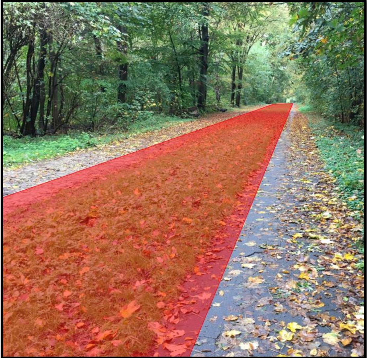
Abb.: Fotomontage der geplanten Trasse - Überlagerung eines strukturarmen Grünstreifens durch 5,00 m breite Trasse (rot) asphaltierte Bereiche in Randbereichen werden entsiegelt - wassergebundene Bereiche lediglich oberflächlich zurückgebaut. (ca. 1.000,00 m) - Fotomontage: AG
