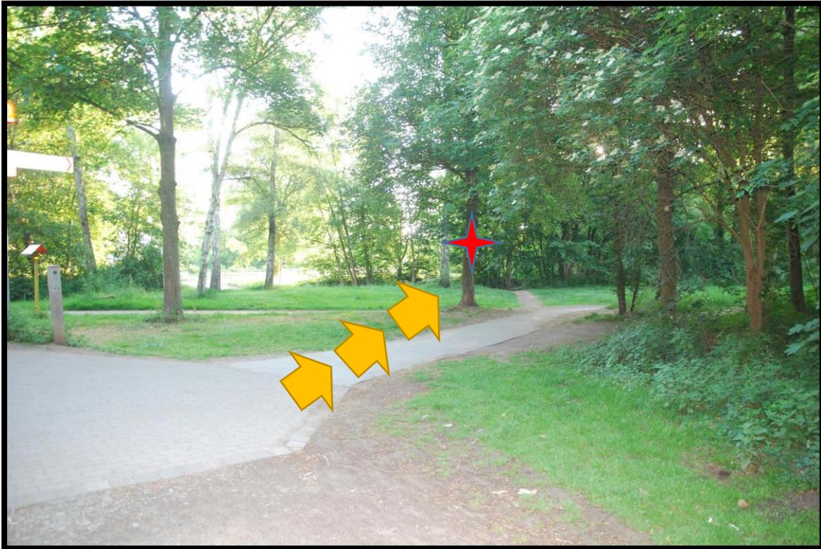
Abb.: Fotomontage der geplanten Trasse - Überlagerung von strukturarmen Vegetationsflächen durch 5,00 m breite Trasse (gelb) asphaltierter Weg wird entsiegelt - ein Baum aus der Baumgruppe muss gerodet werden (rotes Kreuz).
