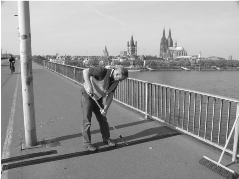
Abb.2: Aufbringen der Sensoren
