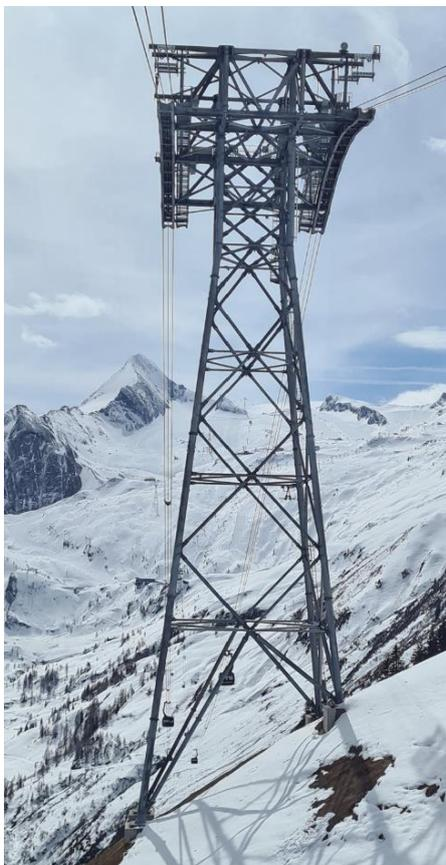
*Abbildung 61: Fachwerkstütze
