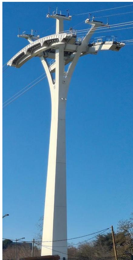
*Abbildung 62: Vollwandstütze,
