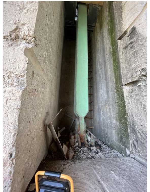
Bild 2: Öffnung des Pendellagers linksrheinisch
